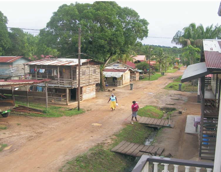
La rue menant au bureau de poste de Papaïchton.
