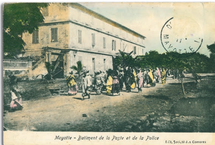
Bâtiment de la Poste et de la Police.
